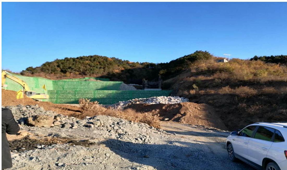
照片 1 场区现状
