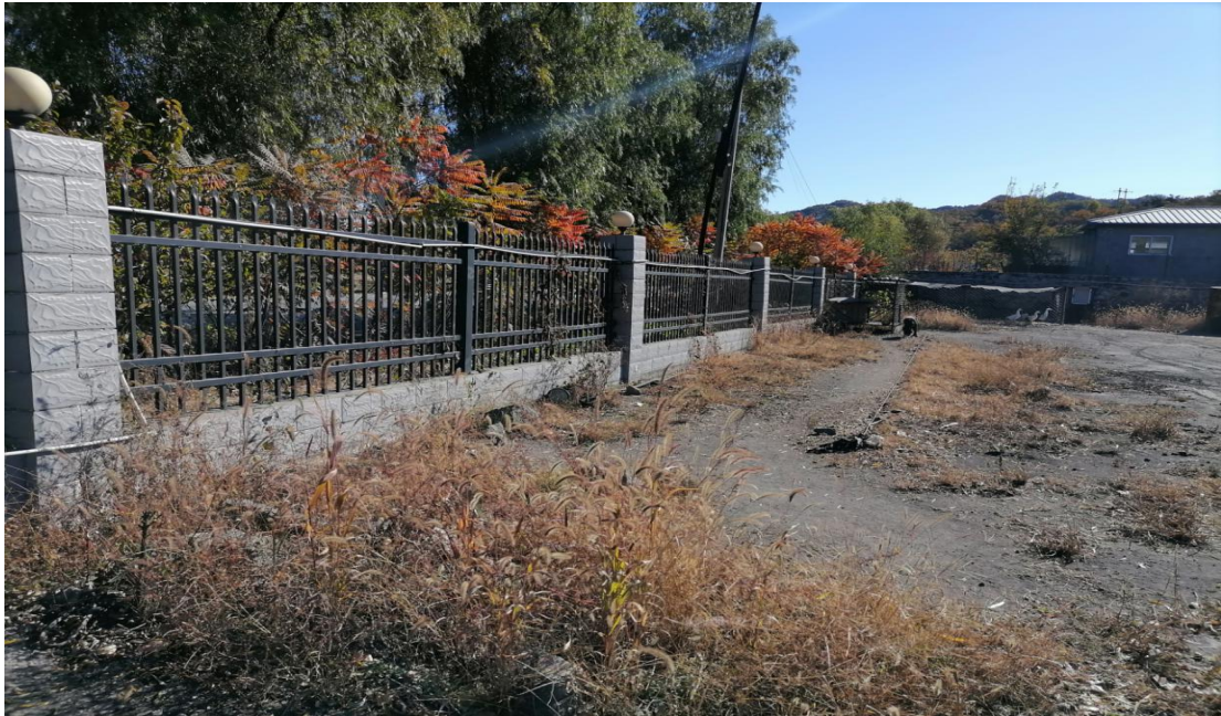
照片 9 运输道路及绿化措施
